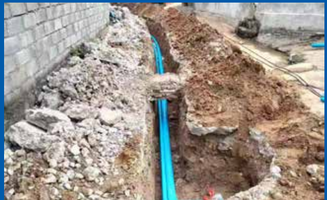
真空排水管道施工
