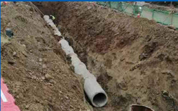
重力流排水管道施工
