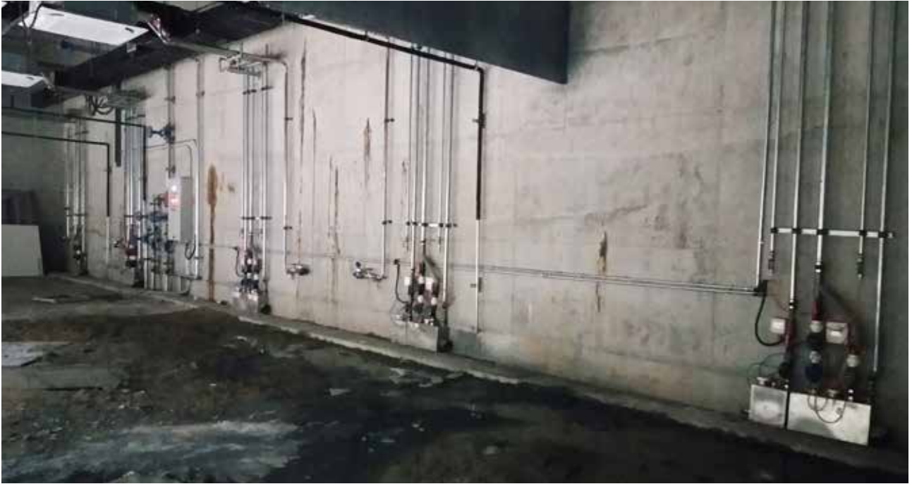
真空管路可以向上提升和水平长距离传输污水
